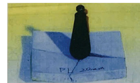
Vữa tô thông thường không chịu được sự va đập
